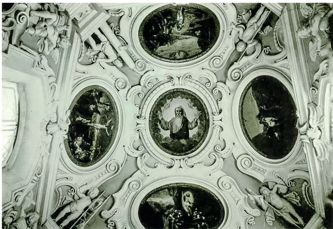
Sklepienie kaplicy Promnitzów, fot. 1939 r.
